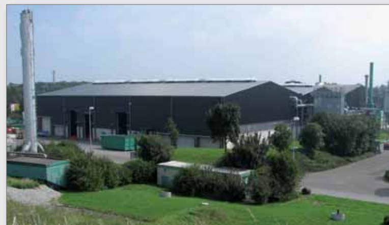
Blick auf die EBS-Anlage
